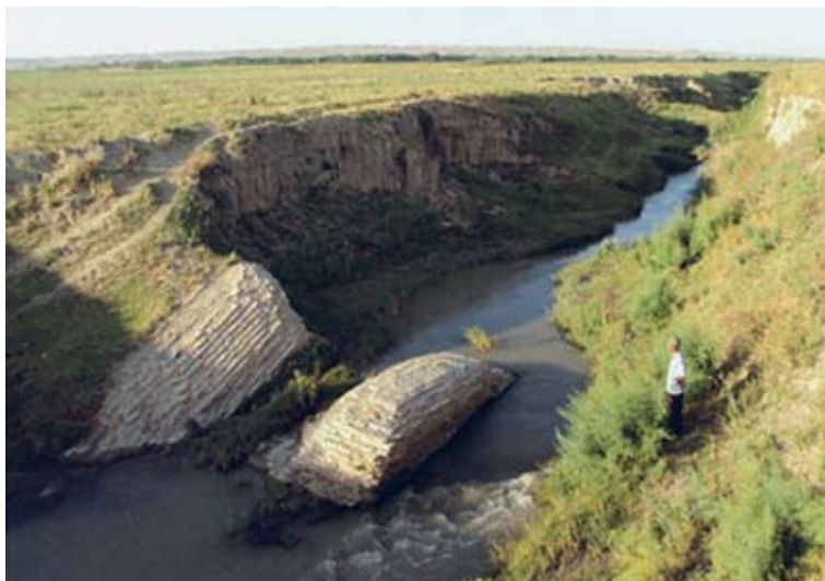
Überreste einer altertümlichen Brücke über den Karasu-Fluss (ungefähr 16. Jh.)
