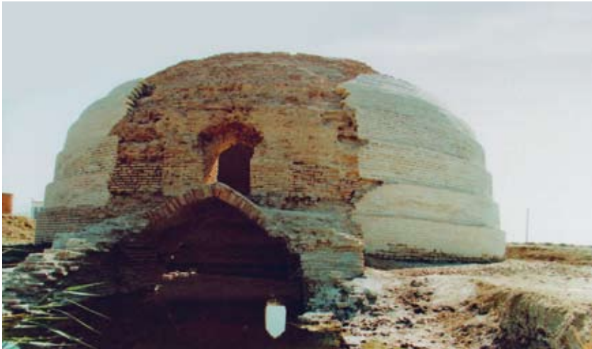
Der alte Trinkwasserspeicher - Sardoba
